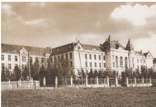
Fig.2.3.1.22.Clădirea fostului gimnaziu catolic(1911)
